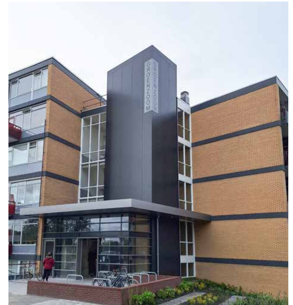
Aan de Groenzoom is een galerijflat uit de jaren '60 geüpgraded en klaargemaakt voor de toekomst. Omdat uitbreiding van de bestaande liftschacht niet mogelijk was, is een nieuwe installatie tegen het gebouw gerealiseerd. Foto onder: Het project Groenzoom in Leerdam afgerond; de entree en de hal rondom de liftschacht.
