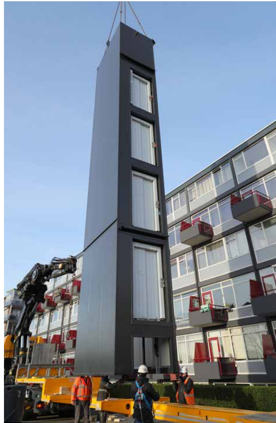
Het hijsen van de prefab liftschacht.
