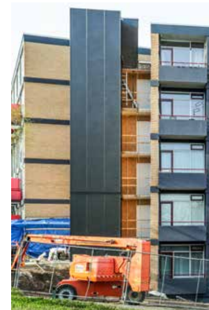
De installatie van de prefab liftschacht.
